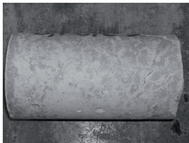
Figura 11. Fisuras a lo largo del perímetro lateral.
