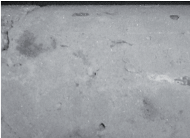
Figura 12: Levantamiento de la pasta.
