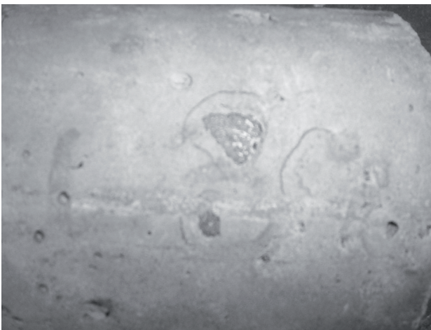
Figura 13: Descascaramiento de la pasta.
